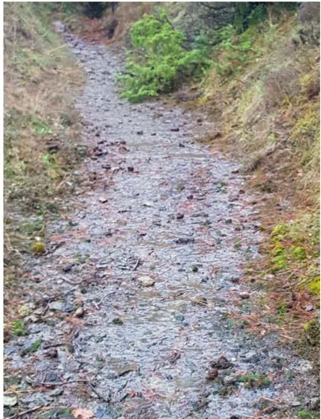
Fossé montant dit la « grande rigole »
